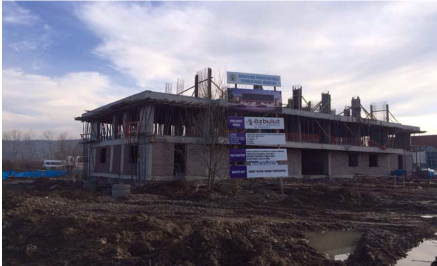
Emniyet Bölge Trafik Hizmet Binası Yapım İşi
