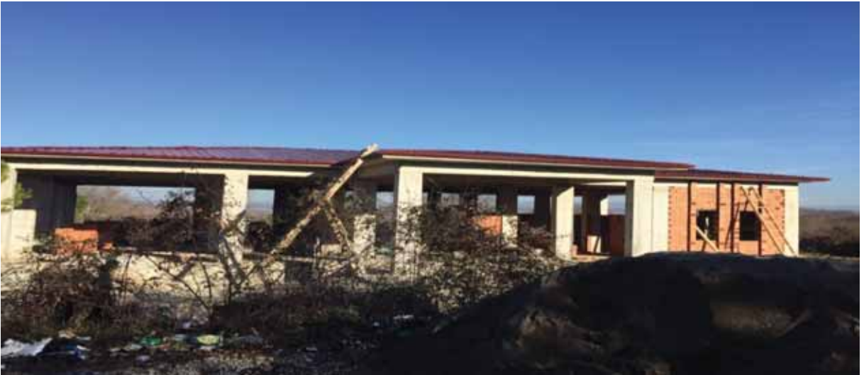
Kızılelma Aile Sağlığı Merkezi İnşaatı
